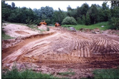
Renaturierungsarbeiten an der Ladenbek 1987
